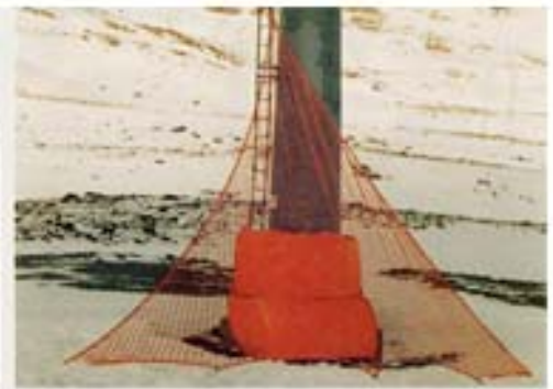
filet de protection pylone
