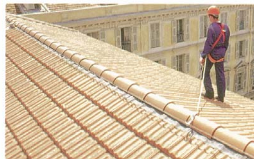
INSTALLATION EN FAITAGE DE TOITURE
