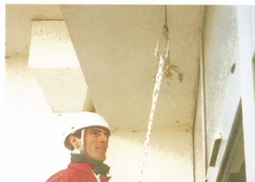
INSTALLATION SUR PLAFOND
