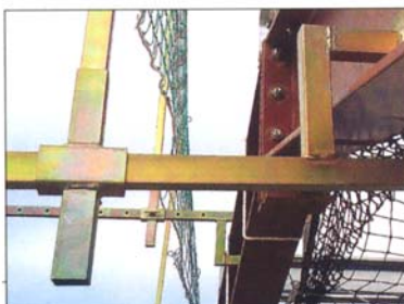
Passage cheneaux - pince posée sous ferme
